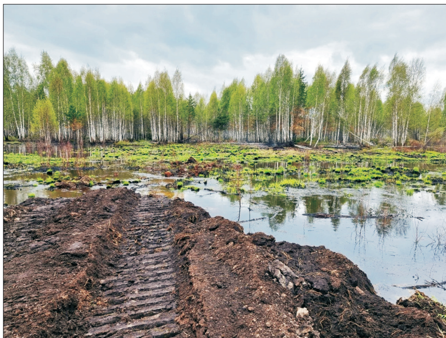
Рис. 5. Гребень плотины и образовавшийся перелив.
