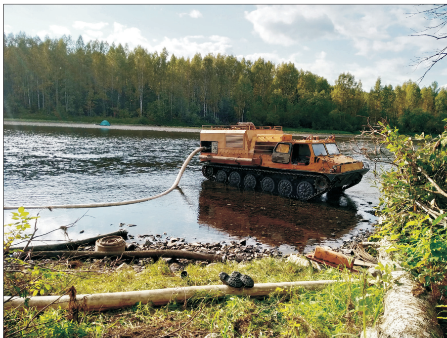
Рис. 6. Насосная станция на базе ГТ-ТМС.
